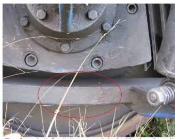
Foto 8 – sudură, fisură și amprente de lovituri în placa de gardă
