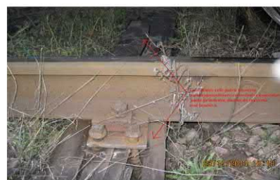
Foto nr.6 – traversă necorespunzătoare
