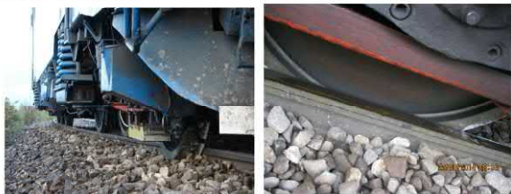
Din primele verificări efectuate la fața locului s-a constatat faptul că, buza bandajului roții din partea dreaptă a acestei osii a escaladat ciuperca șinei corespunzătoare firului exterior al curbei, a
